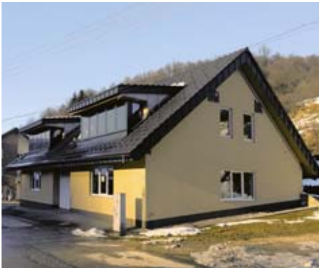
MTS Krivá, ubytovne pre zamestnancov
